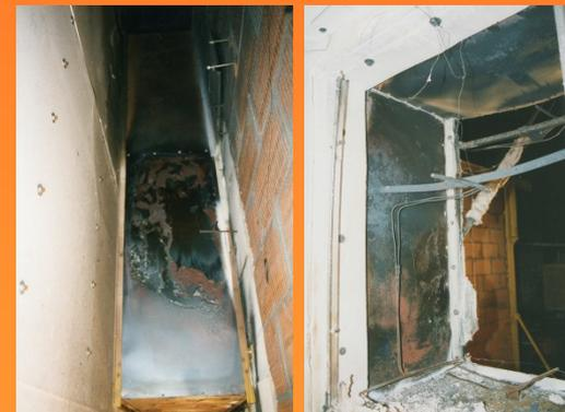
Zwischenfassadenbereich: links: Stahlabschottungen nach dem Brand intakt (Rauchdichtheit nicht überprüft), rechts: unteres Kastenfenster ohne Scheiben
