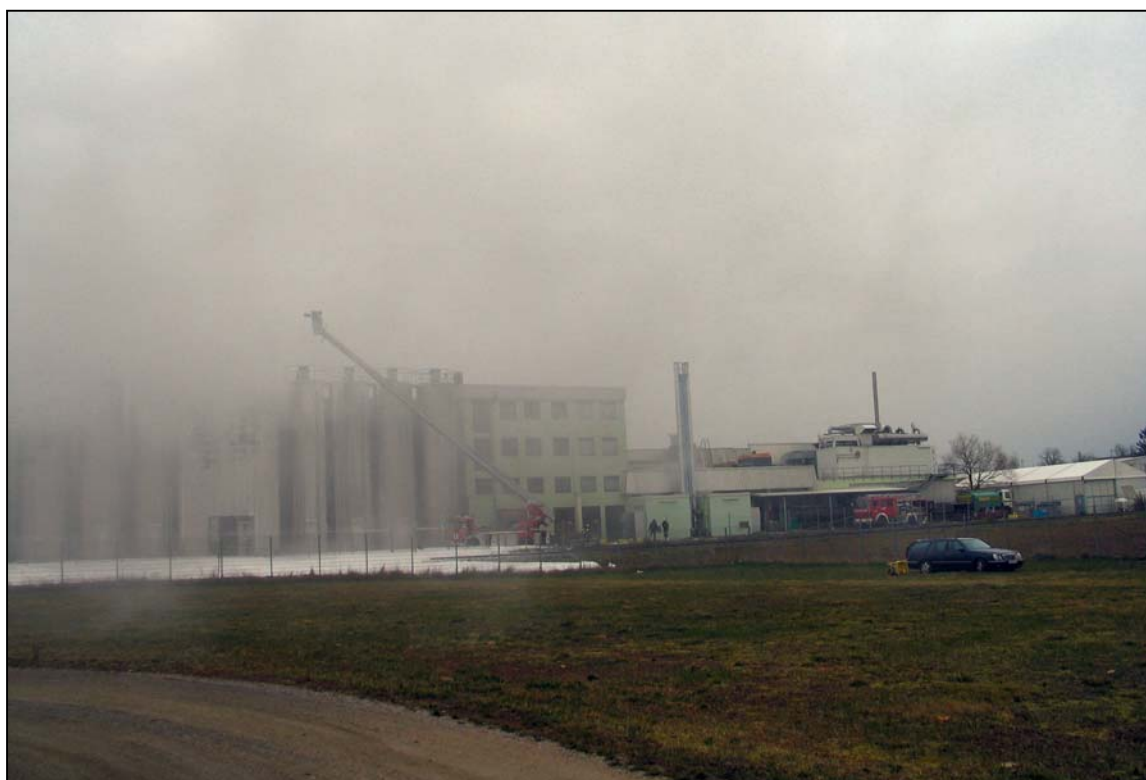
Foto Brandstelle 11:20 Uhr, rechts Messfahrzeug, (Foto P. Basmer)
