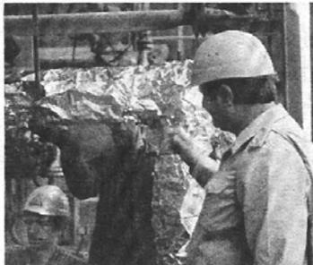
*Die ordnungsgemäße Isolierung heißgehender Rohrleitungen (Foto oben) gehört ebenso zur Wintervorbereitung wie entsprechende Arbeiten an elektrischen Begleitheizungen (Foto unten). In beiden Fällen geht es um Probleme des Brandschutzes und der Energieökonomie. Fotos: Autoren*
