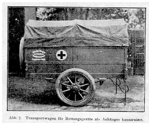
Abb. 2. Transportwagen für Rettungsgeräte als Anhänger konstruiert.
