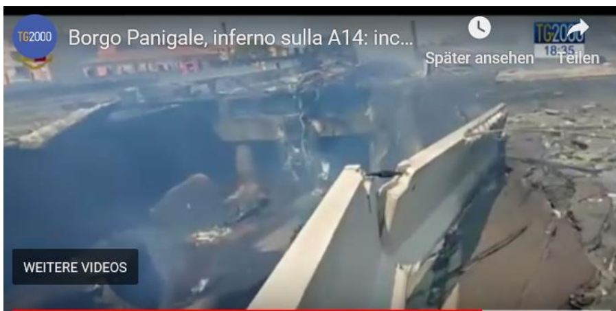
Abb. 34: Die zerstörte Hochstraße /43/
