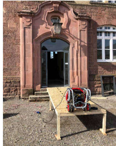
Abb. 49: Lüfter vor geöffneter Tür. (H=210cm x B=97cm)
