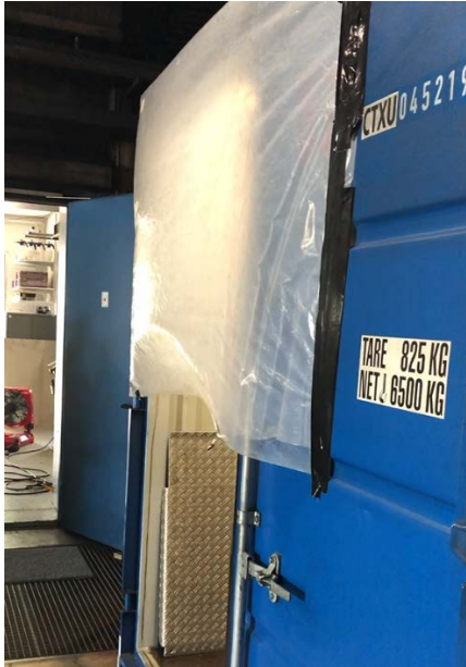
Abb. 31: Nach außen gewölbte Türabdeckung Container
