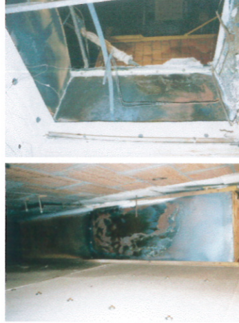
Außenfassade: ESG-Scheibe hat während der Brandbelastung ihre Vorspannung verloren und fällt vollständig aus dem Aluminiumprofilsystem
