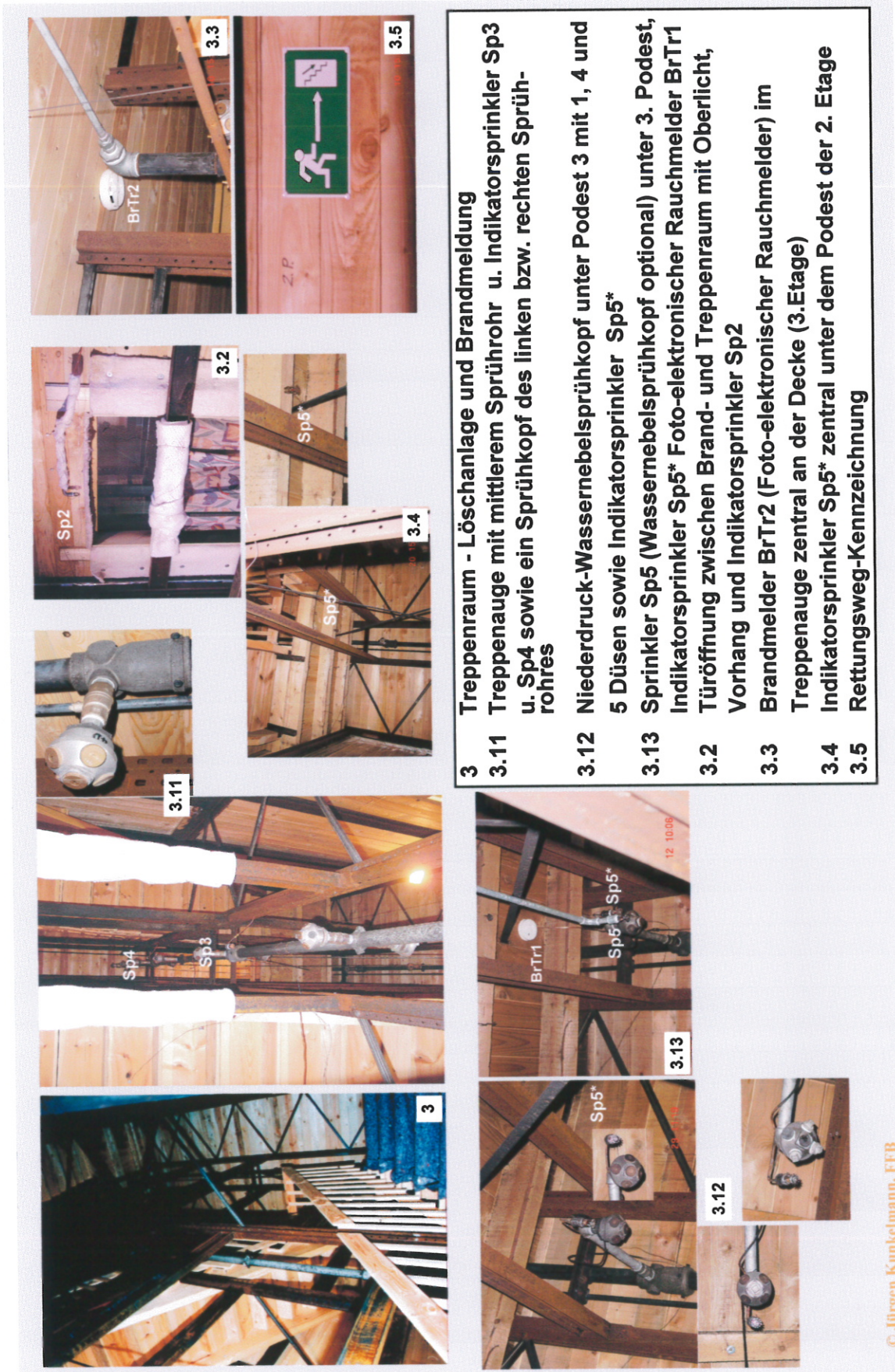
Bild 1.3: Versuchsholzgebäude mit Niederdruck-Wassernebellöschanlage in der Brandversuchshalle der Forschungsstelle für Brandschutztechnik. - Treppenraum
