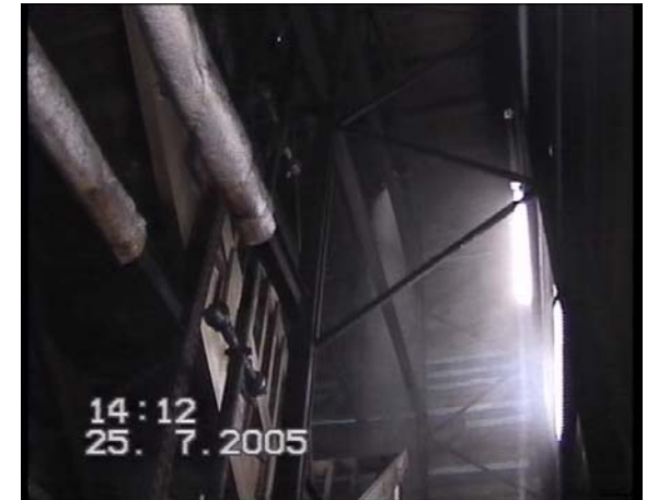
Einzeldüse im Treppenraum 135 bar
