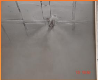
Sprühkopf mit 4 Düsen 135 bar
