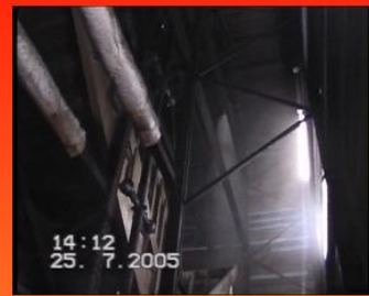
Einzeldüse im Treppenraum 135 bar
