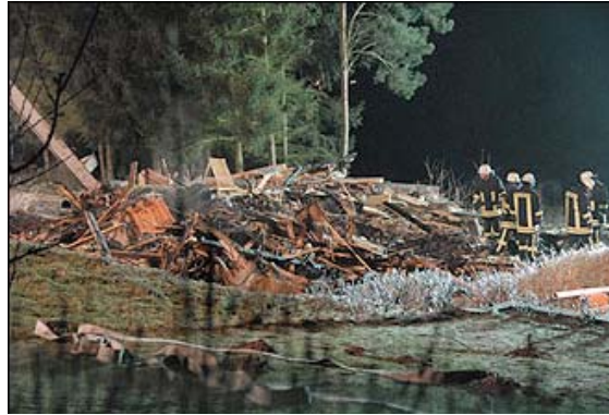
Bild 2-2 Überreste des Hauses nach dem Abriss durch einen Bagger [www.osthessen-news.de]
