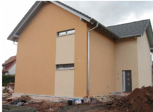
Bild 7-6 Nordseite eines Passivhauses [ www.passivhaus-info.de ]
