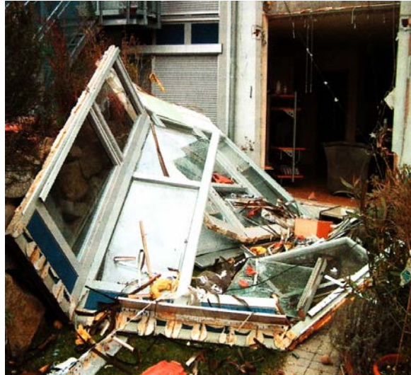
Bild 5-12 Auswirkungen eines Backdraft auf eine Fensterfront [Riehl, 2003]
