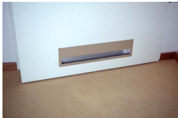
Bild 4-4 Überströmöffnung im Türblatt [Schulze Darup, 2008]
