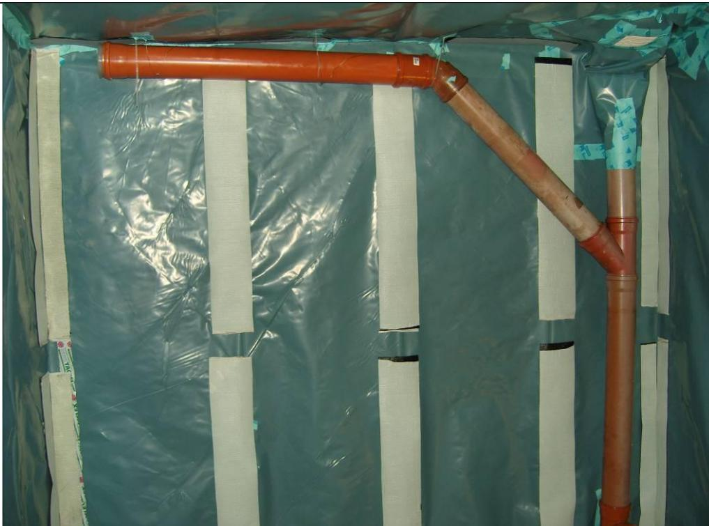
Abbildung 7: Versuchslabor – Bauphase: Lüftungskanäle und verklebte Dampfsperrfolie zur Abdichtung vor der Holzkonstruktion.
