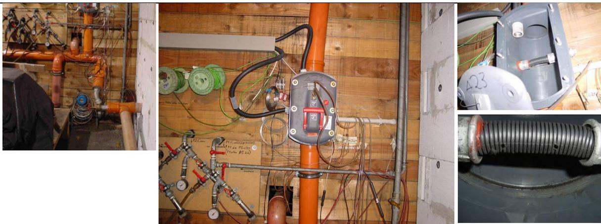
Abbildung 21: Löschwasserzuführung zum Versuchslabor (Niederdruck-Wasserversorgung), Lüftungsleitungen (Zusammenführung von Abluft aus Labor und Schleuse in Steigrohr zur Absaugung durch die Rauchreinigungsanlage), Gehäuse (grau) einer Rückstauverschlussklappe mit unterer Rauchansaugsystem (RAS)-Messstelle und Rückführleitung (schwarze Rohre, Bild rechts: Ansaugöffnungen).
