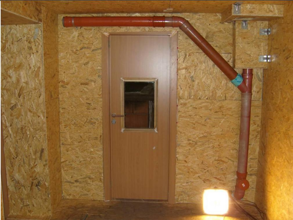
Abbildung 8: Versuchslabor – Bauphase: Holzverkleidung (OSB-Platten) über der Dampfsperrfolie.
