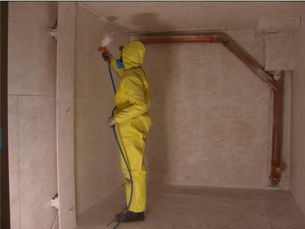
Abbildung 9: Bauphase: Versiegelung der OSB-Platten gegen das Eindringen von Feuchtigkeit, statische Differenzdruckmessstellen (Bild links: 20 cm über dem Boden, halbe Raumhöhe und 20 cm unter der Decke).
