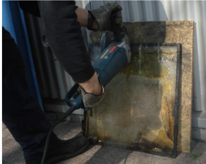
Abbildung 8-6: Einsatz des Trennschleifers an VSG – Scheibe
