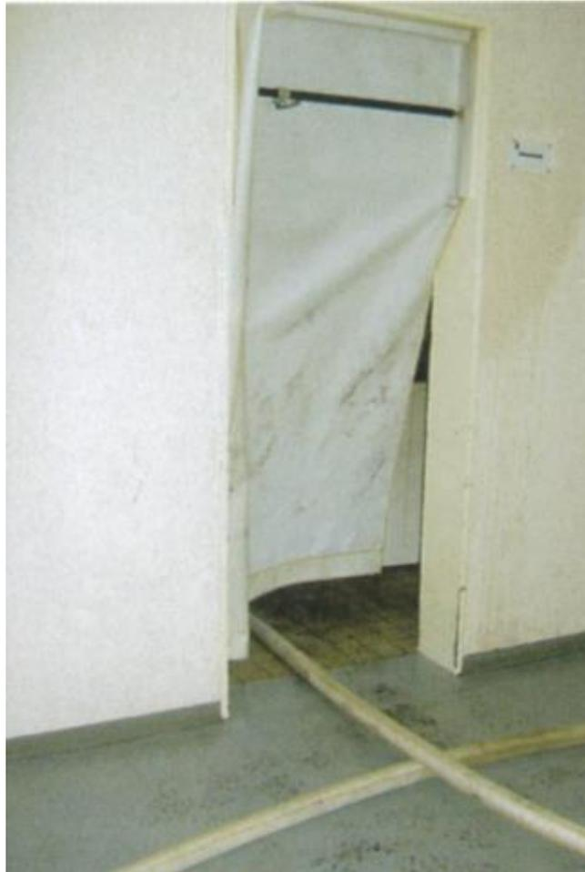
*Abbildung 3.1: Der mobiler Rauchverschluss wurde im Türrahmen einer Wohnungsabschlusstür installiert [33]. Im vorliegenden Fall war es die Tür zu einem Raum mit Waschmaschinen und Wäschetrockner in einer großen Wohneinheit [50].*
