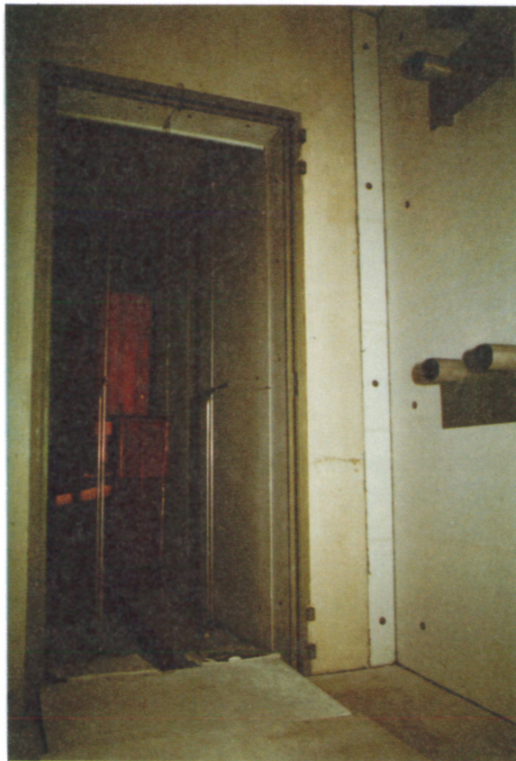
Bild 4: Blick von der Schleuse in den Brandraum
