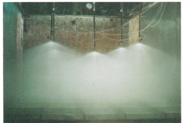
Bild 16b. 5 Sprinklerdüsen im Einsatz in 1,50 m Höhe.
