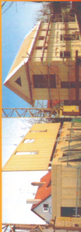
Bild 11: Beispiel für den Aufbau eines Gebäudes in Holzblocktafelbauweise.
