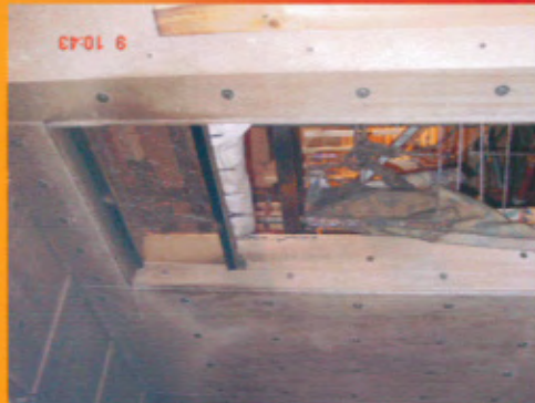
Oberlicht über der Türöffnung: Treppenraum > Brandraum mit Rißbildung, Vorhang teilweise verbrannt
