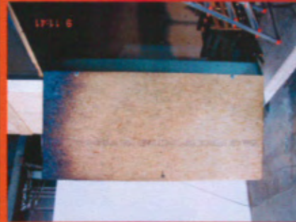
Oberlicht über der Türöffnung: Treppenraum > Brandraum mit Rißbildung, Vorhang teilweise verbrannt
