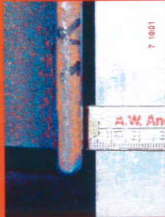
Stahlträger 3 (Hinterer Bereich) Durchbiegung: ca. 4 mm
