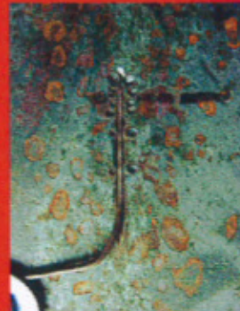
Temperaturmeßstelle am Stahlträger
