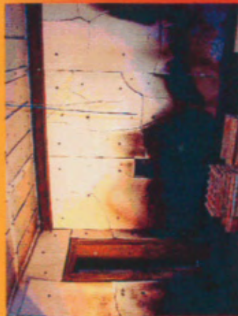
Brandraum mit Stahlträger 3 und Brandraumtür
